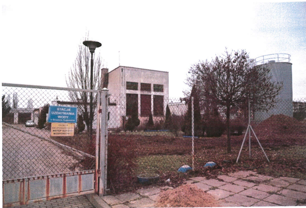
Stacja Uzdatniania Wody w Brześciu Kujawskim
