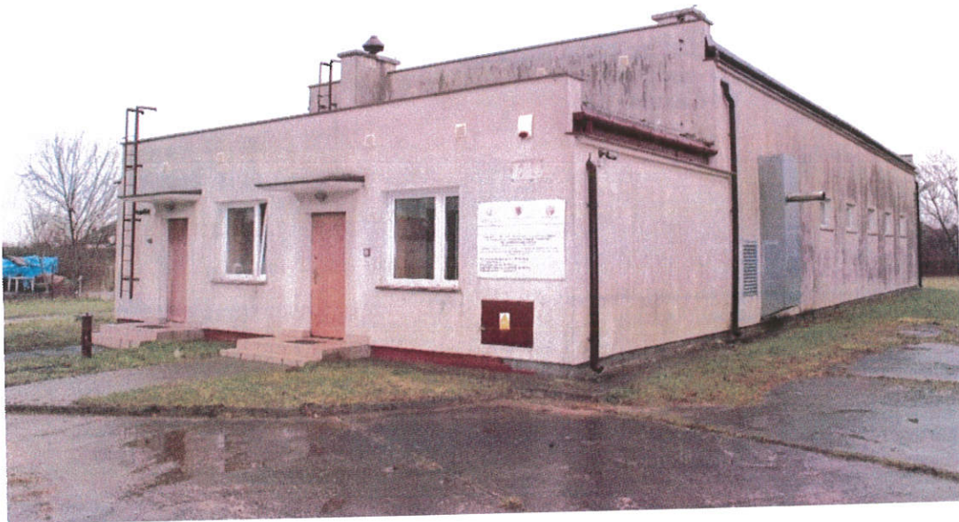
Stacja Uzdatniania Wody w Brzeziu
